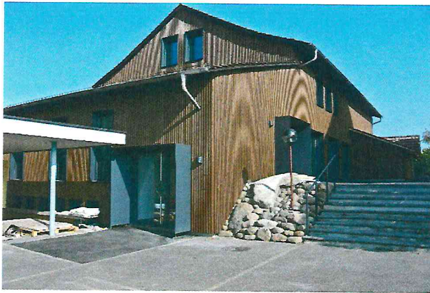
Abbildung 1: Aussenansicht neue Fassade Buechwäidsaal
