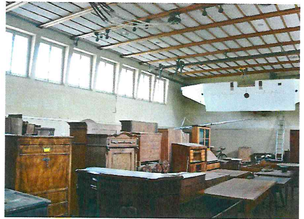
Abbildung 4: Innenansicht ehemalige Turnhalle
