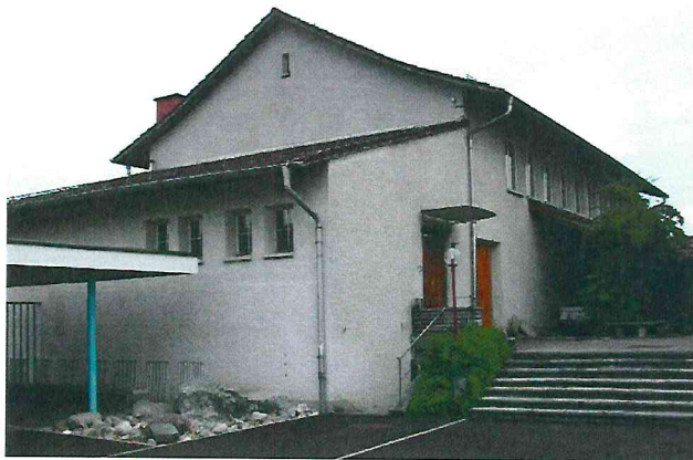
Abbildung 3: Aussenansicht alte Fassade
