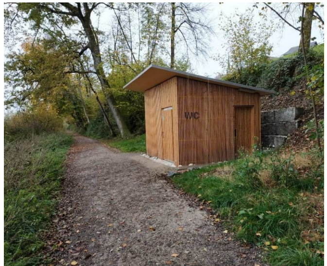
Toilettenanlage am See
