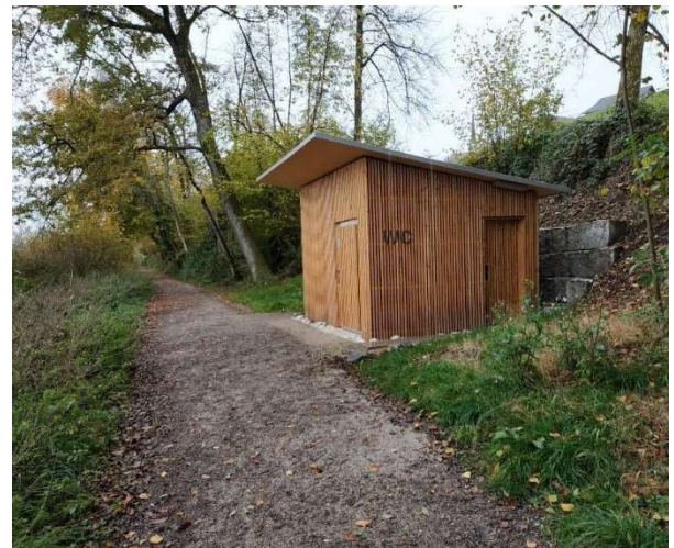
Fertiggestellte Toilettenanlage am See
